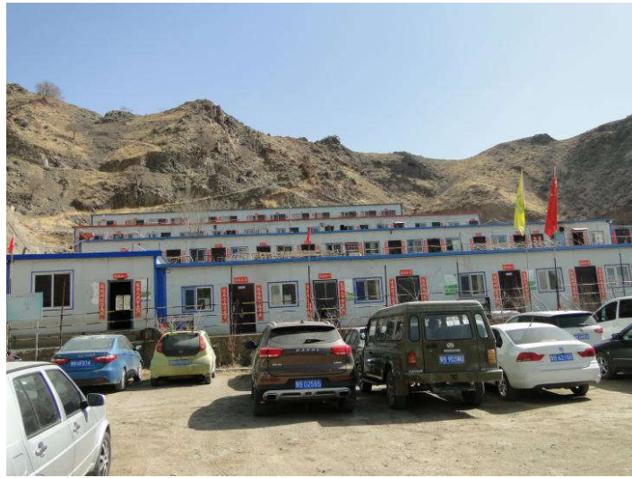
照片 11 32 号工业场地
