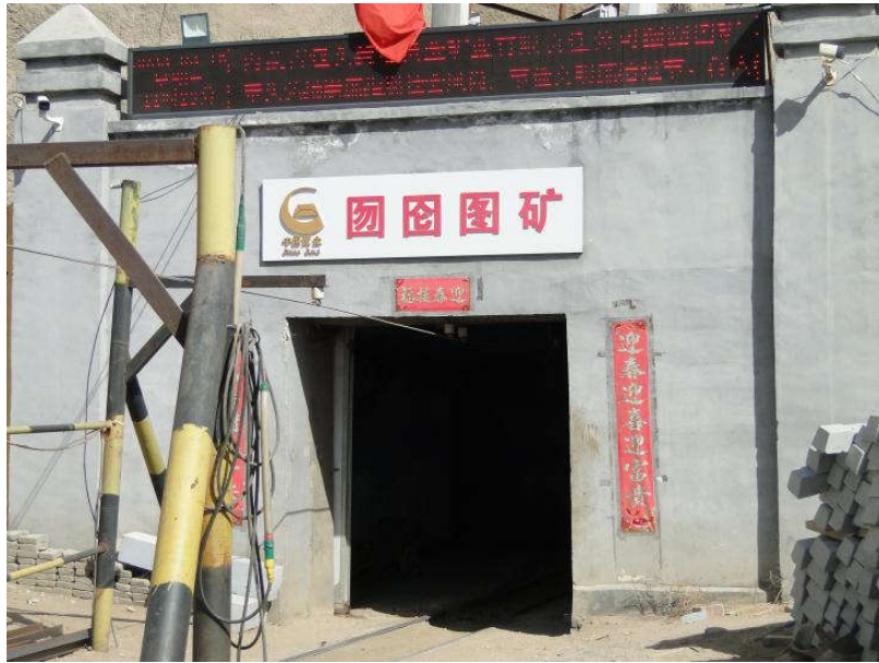
照片 15 32 号竖井井口
