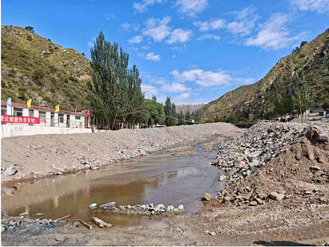
照片3 113号脉河道治理后照片
