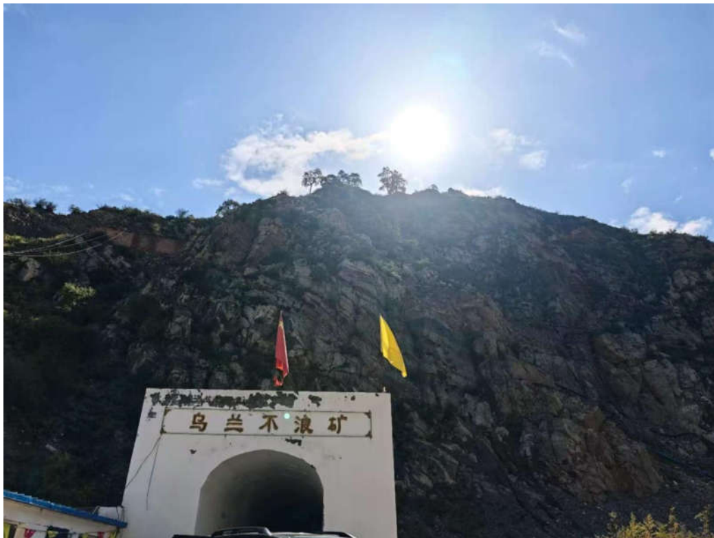
照片 2 113 号脉工业场地平硐出口治理后照片
