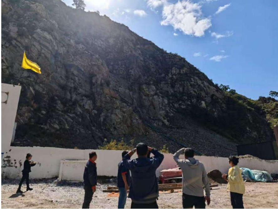
照片 1 113 号脉工业场地废石堆治理后照片
