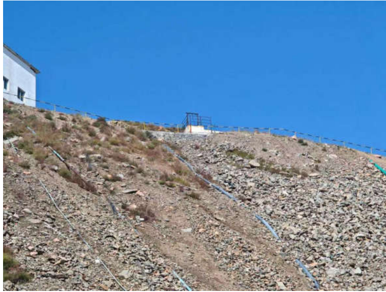
照片5 24号脉工业场地废石堆治理后照片
